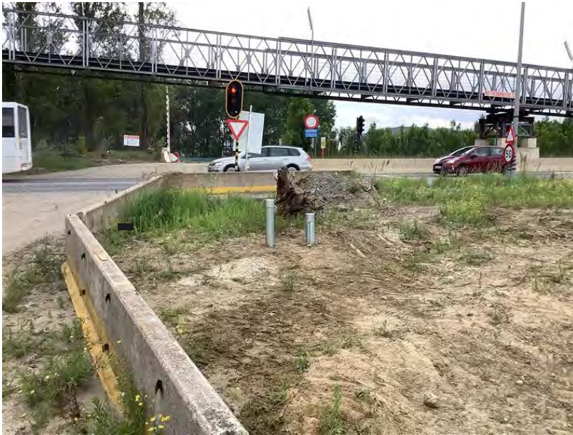
Landstrook tussen de 3M-site en de Palingbeek
