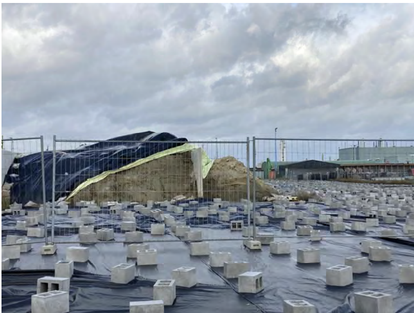
On site voorzorgsmaatregel Controle afdekking te saneren zone voor bouw nieuwe waterzuivering (zone Atlantis) in afwachting van de sanering
