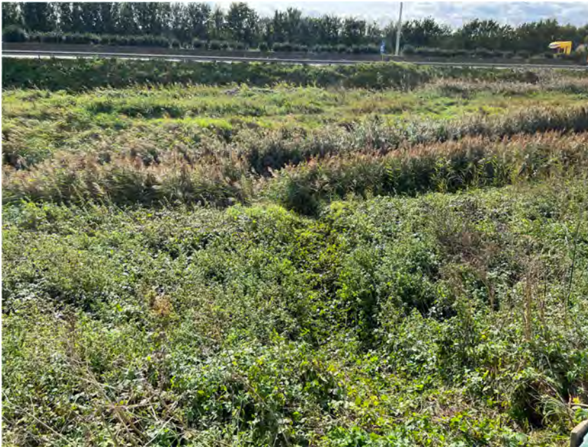
De Karperreed ter hoogte van SE3571
